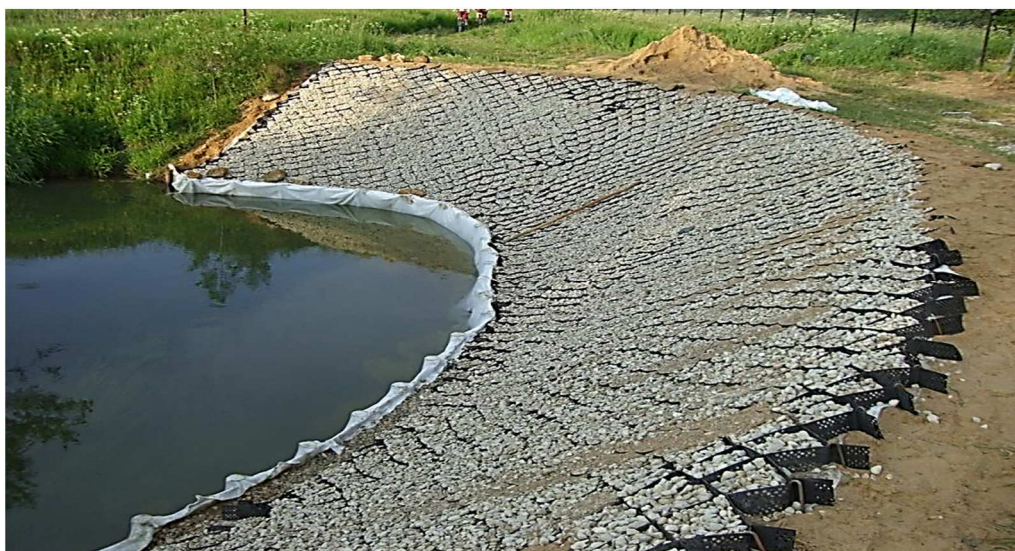
Рисунок 3 – Применение георешетки для укрепления грунта [7]
