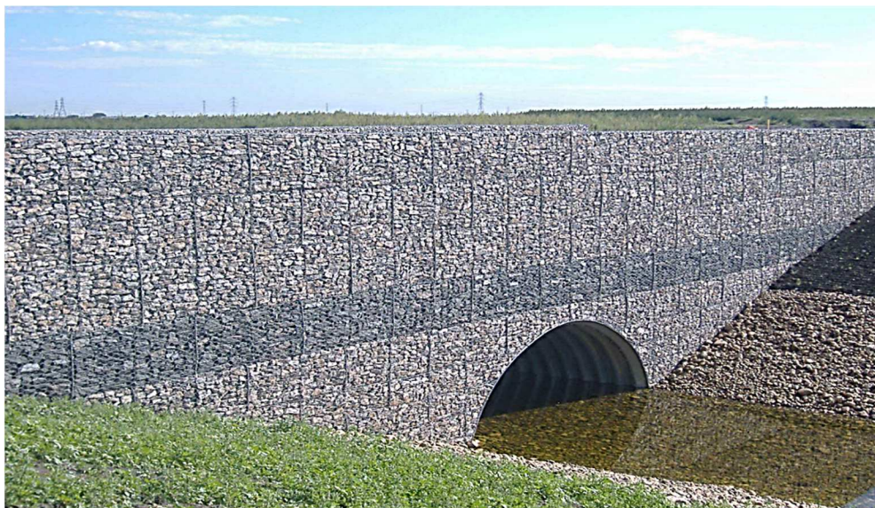
Рисунок 4 – габион в конструкции дамбы [9]
