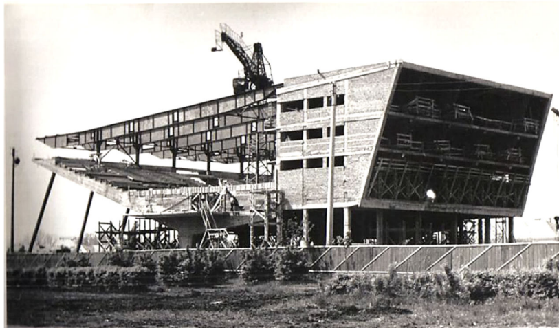
Рисунок 2 – Общий вид строящегося кинотеатра 1967 год
