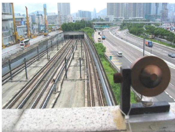
Рисунок 3 – Автоматизированный геодезический мониторинг при помощи прецизионной линзы
