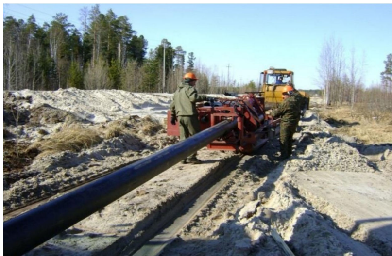
Рисунок 12 – Стыковка футерованных трубопроводов методом обжима в полевых условиях
