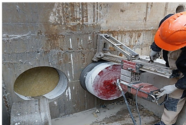
Рисунок 1 – Техника и приемы работы алмазной резки
