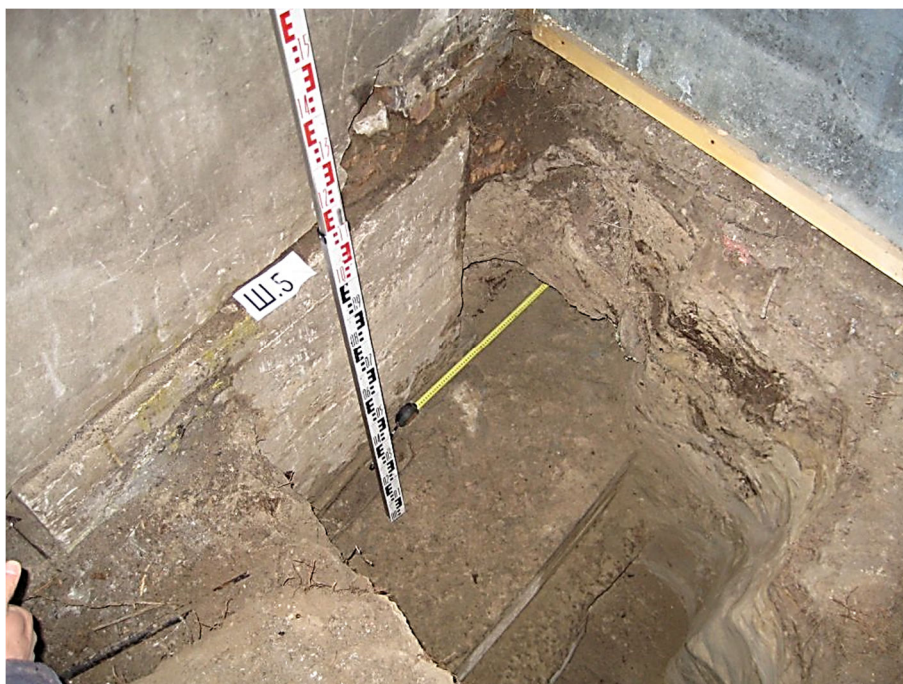
Рисунок 1 – Обследование фундамента методом раскопа шурфов
