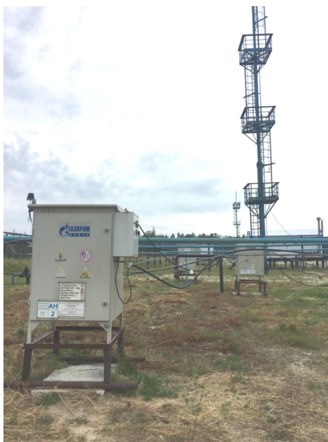
Рисунок 4 – Установка дозирования химического реагента
