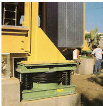
Рисунок 6 – Пружинный демпфер под трехэтажным домом
