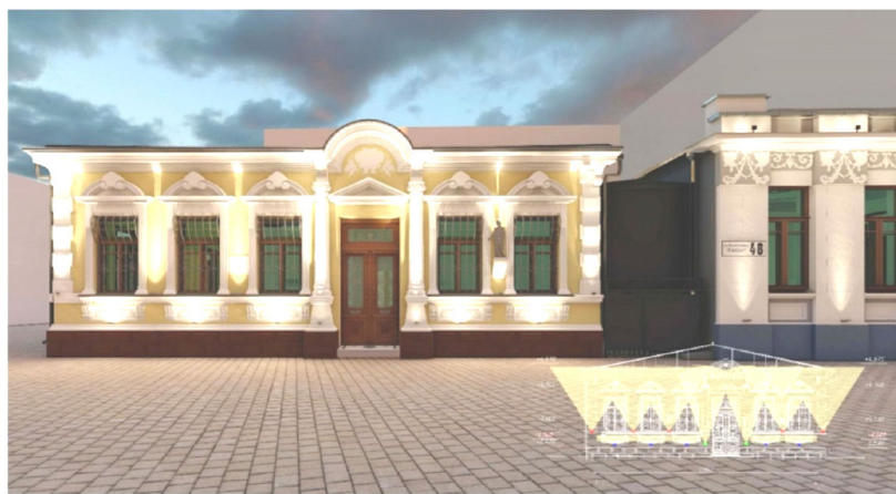
Рисунок 3 – Жилой дом Пятковой (эскиз реконструкции), фото пресс-службы мэрии Краснодара [5]
