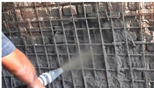
Рисунок 1 – Обработка поверхности кирпичной кладки торкрет-бетоном
