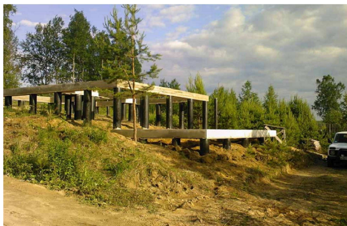
Рисунок 2 – Уплотнение грунта для столбчатой конструкции основания дома
