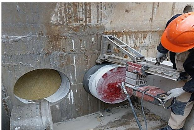
**Рисунок 1** – Техника и приемы работы алмазной резки
