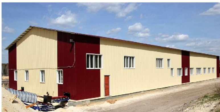
Рисунок 3 – Внешний вид двухэтажного промышленного здания
