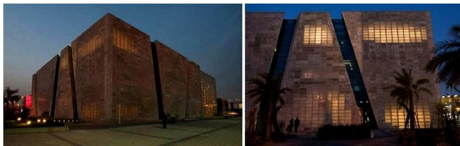
Рисунок 4 – Здание из прозрачного бетона
