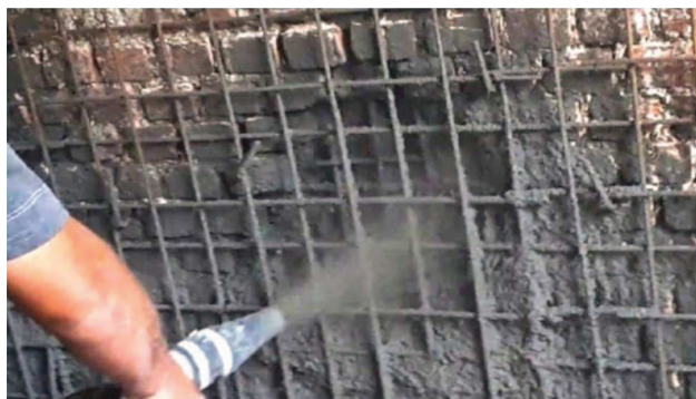
Рисунок 1 – Обработка поверхности кирпичной кладки торкрет-бетоном
