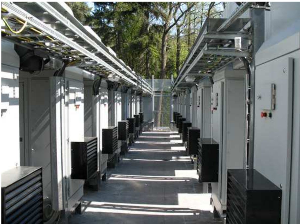
Рисунок 6 – Энергетический комплекс на базе микротурбинных установок TA-100RCHP производства компании «Capstone Turbine Corporation»
