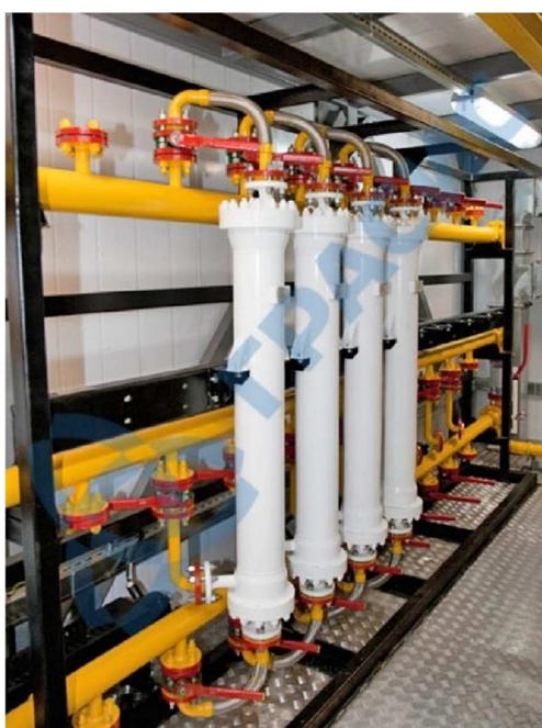
Рисунок 10 – Углеродная установка удаления сероводорода из газового потока
