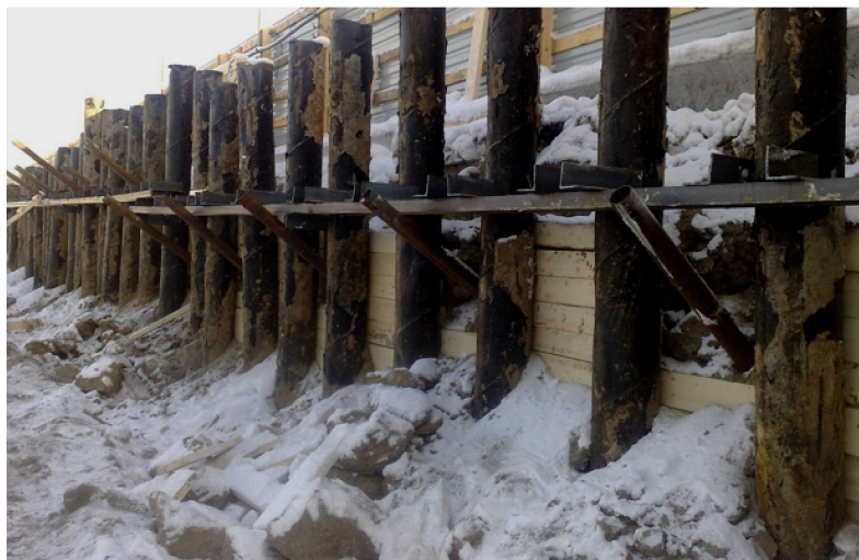
Рисунок 1 – Шпунтованное ограждение на откосе
