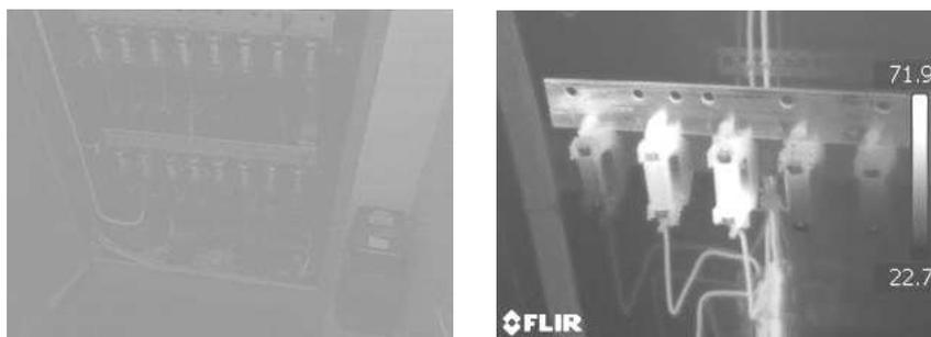
Рис. 5. Результаты тепловизионной съемки PY-0,4 кВт
