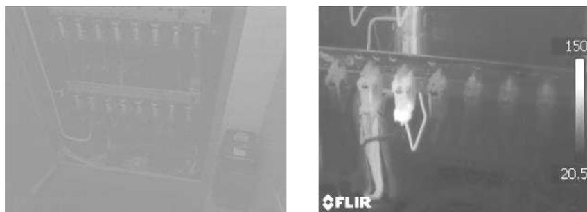
Рис. 4. Результаты тепловизионной съемки PY-0,4 кВт
