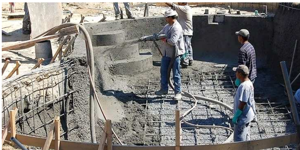
Рисунок 3 – Торкретирование стен бассейна [4]
