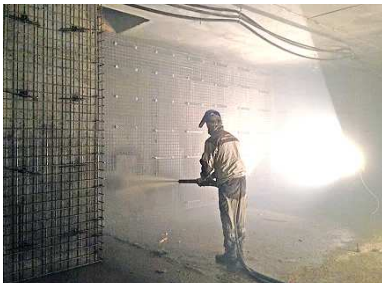
Рисунок 4 – Торкретирование стен высотного здания [5]
