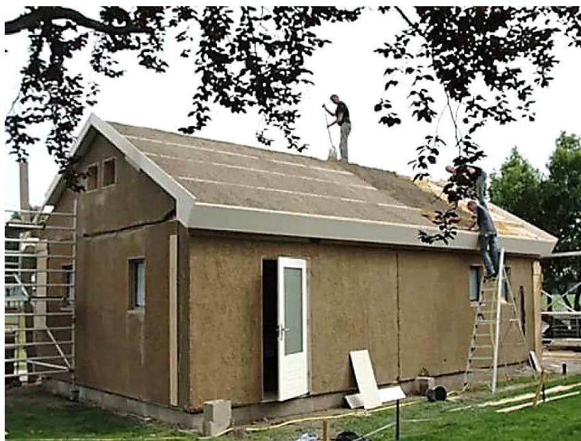
Рисунок 3 – Строеение из костробетона
