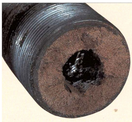
Рисунок 1 – АСПО в трубе
