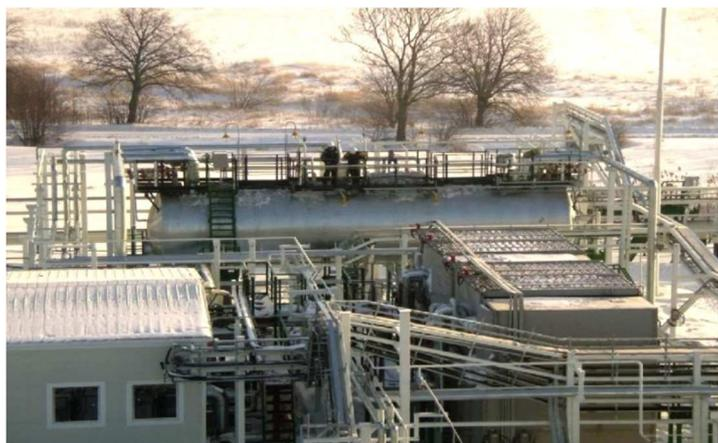
**Рисунок 2** – Вид гидроприводных струйных компрессорных агрегатов на пункте сбора нефти и газа «Романово» (г. Калининград)
