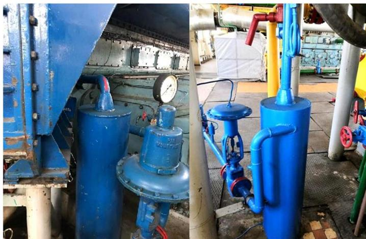
**Рисунок 2** – Установленный центробежный сепаратор перед входом ГПА
