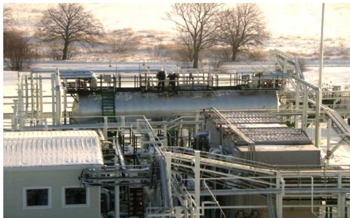
Рисунок 2 – Вид гидроприводных струйных компрессорных агрегатов на пункте сбора нефти и газа «Романово» (г. Калининград)
