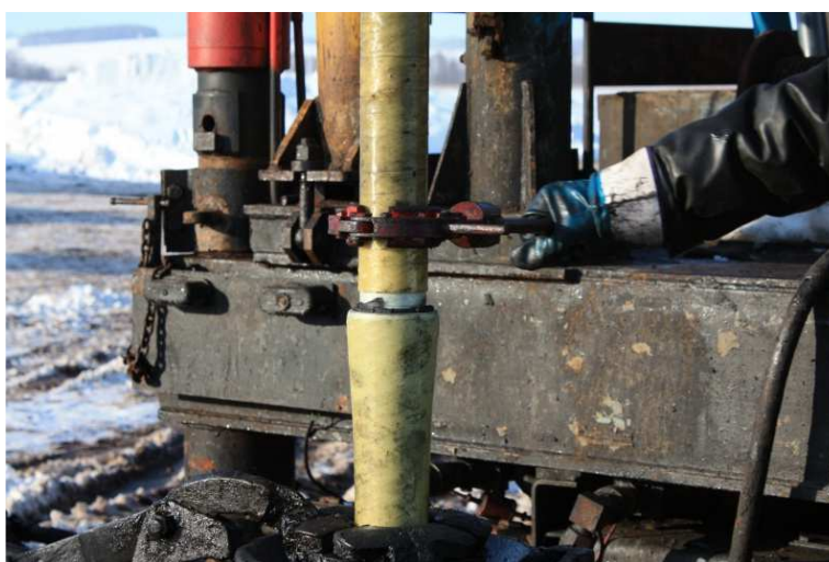
Рисунок 2 – Стеклопластиковая труба на буровой установке
