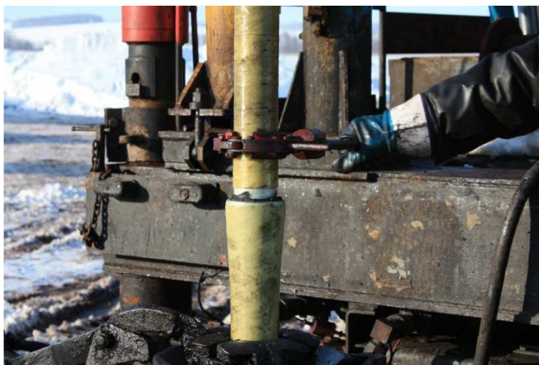
Рисунок 2 – Стеклопластиковая труба на буровой установке
