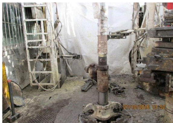
Рисунок 3 – Закачка готовой смеси в скважину через цементировочный переводник на бурильный инструмент
