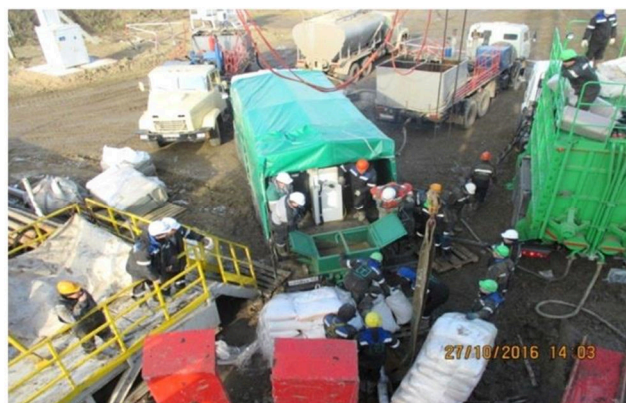
Рисунок 2 – Установка и обвязка спецтехники на скважине, подготовка технологического оборудования к работе, затаривание наполнителей в УСО-20
