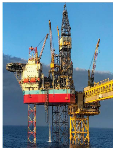
Рисунок 9 – Самоподъемная ПБУ «Maersk Highlander» компании Maersk Drilling
